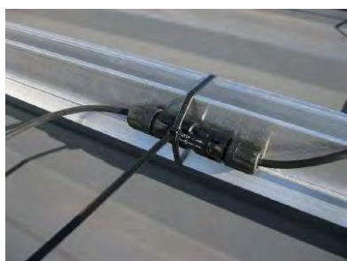
Fixation des connecteurs préconisée
