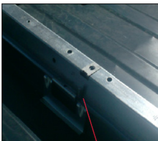
Écrou bord de tôle après la pose
