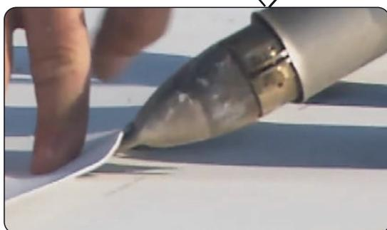
A l'aide du matériel nécessaire, pointer le patch de renfort et souder toutes les bandes de maintien à la partie courante, en respectant scrupuleusement les règles de l'art.
