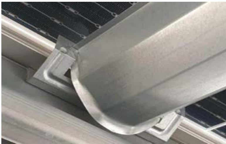
Présenter la traverse universelle légèrement en diagonale pour la positionner dans le clip TU +MALT. Exercer une légère pression à chaque extrémité de la traverse universelle pour insérer les bords dans les fentes des clips TU + MALT.
