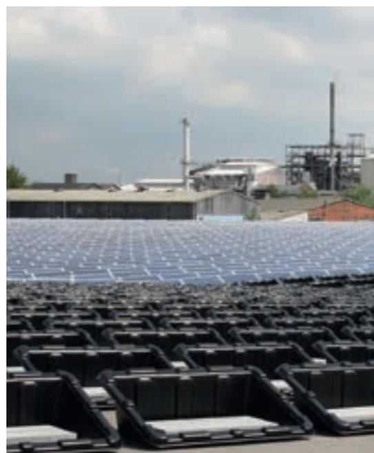
À proximité des ConSoles, il ne doit pas y avoir de pierres détachées (par exemple, il n'est pas opportun de répandre du gravier sur le sol pour limiter la pousse d'herbe, car le gravier peut être soulevé par des oiseaux et ainsi rayer les modules solaires).
