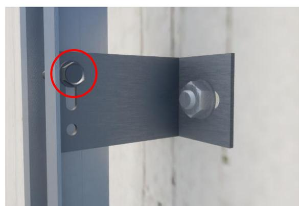
Le profilé devra être mis parfaitement d'aplomb grâce aux réglages que permet le système.
