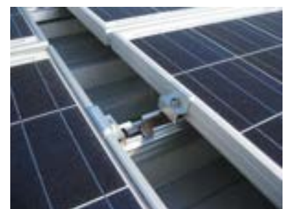
Au joint de dilatation
