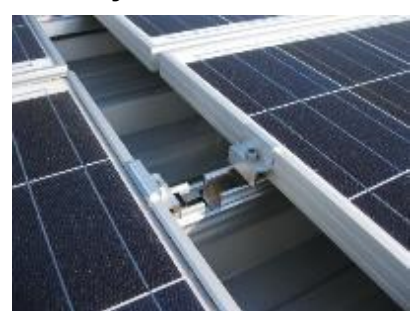
Au joint de dilatation
