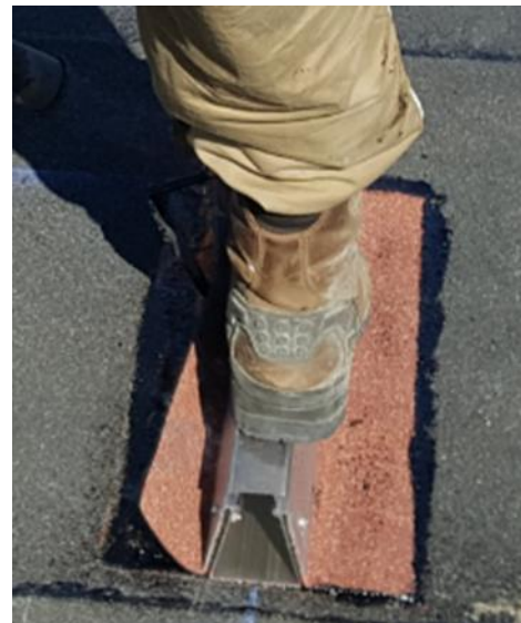
Soudure de la seconde bande de maintien
