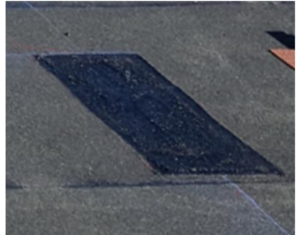
Soudure de la seconde bande de maintien
