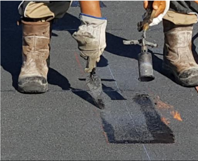
Soudure de la première bande de maintien
