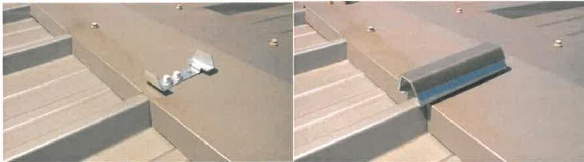
***Positionnement des rehausses de faîtage : une seule par colonne de rails***
