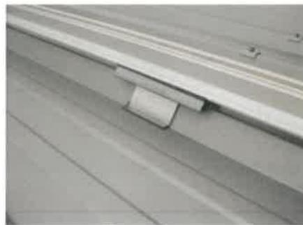
Le premier rail est posé et fixé en bas de pente avec un porte-à-faux maximum de 200 mm (série S) ou 230 mm (série M) par rapport à l'axe de la rehausse inférieure et au minimum à l'aplomb de l'extrémité basse de la rehausse inférieure.
