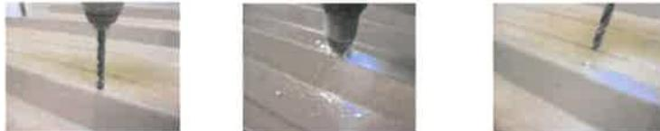
Éliminer l'isolant remonté à la surface et les copeaux de perçage pouvant se trouver sur la peau extérieure du panneau sandwich.
