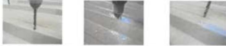
Éliminer l'isolant résiduel à la surface et les copeaux de perçage pendant le trou sur la partie inférieure du panneau sandwich.
