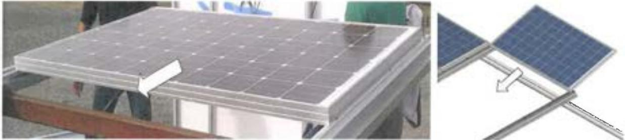
**Étape 2 :** insérer les Clips TU + MALT (ACI383) à chaque jonction de module dans la colonne
