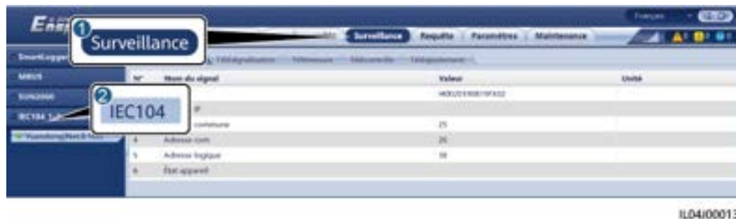
Figure 6-62 Surveillance des appareils
